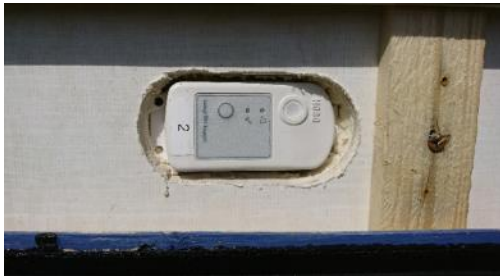
Figur 42 Fotografi på datalogger 2 monterad i luftspalt.
