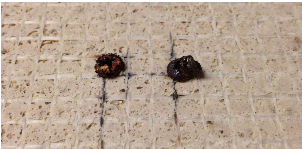
Figur 69 Beläggning som uppstått på elgalvaniserade skruvar efter ett par veckors exponering i ca 95 % RF.
