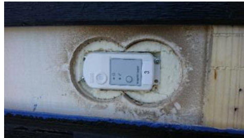
Figur 43 Fotografi på datalogger 3 monterad i luftspalt.
