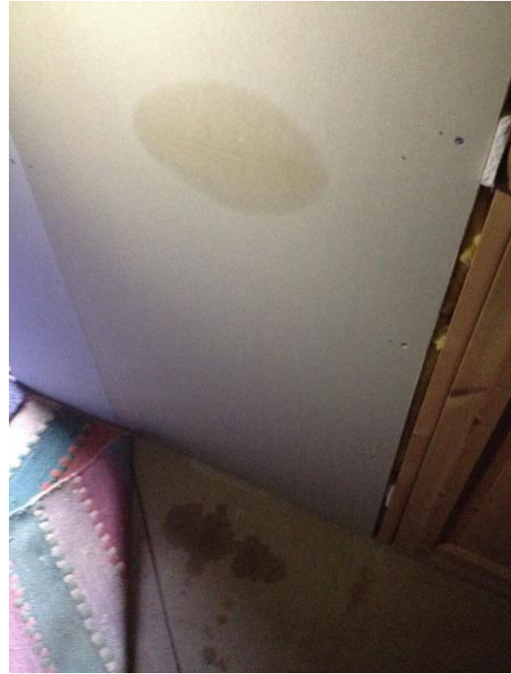
Figur 63 Saltpåverkad gipsvägg och golvspånskiva där en MgO-skiva tidigare stått lutad mot väggen.
