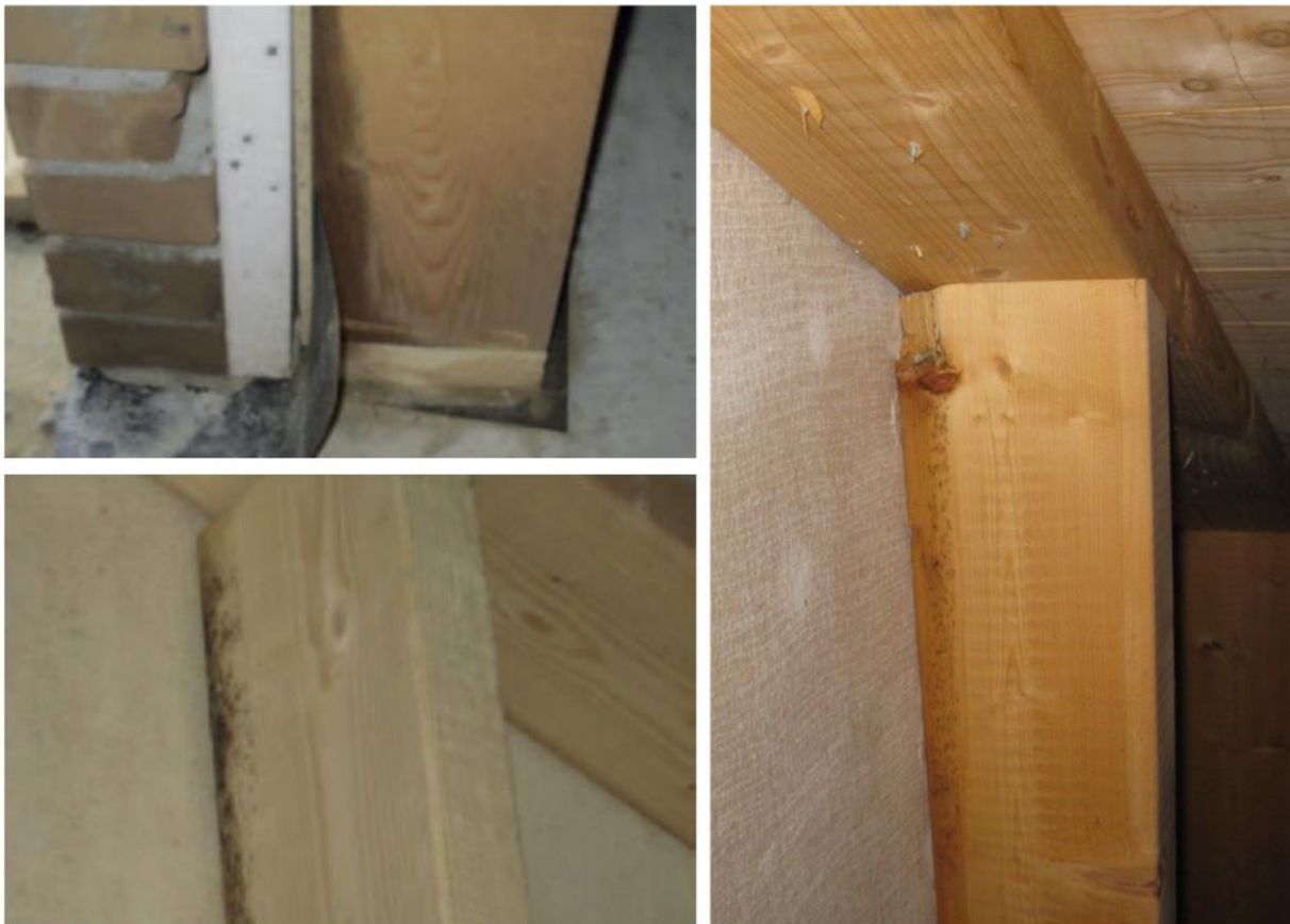
Figur 31 Tre olika konstruktioner med synlig mikrobiell påväxt i anslutning till saltpåverkad träregelstomme. Bilderna till vänster är hämtade från ByggErfa (2016) och den högra bilden är tagen på kallvinden i ett objekt i södra Sverige
