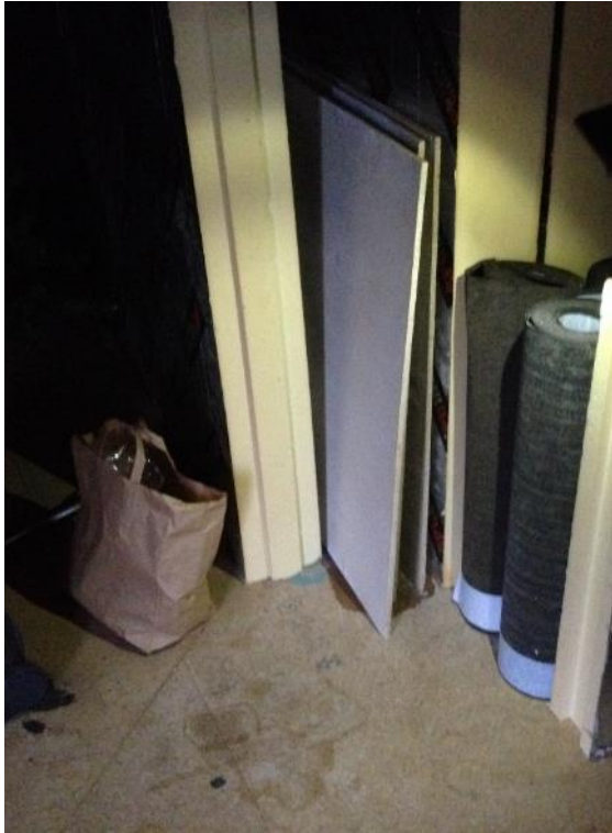
Figur 62 Kallvind sydvästra Skåne där lagrade MgO-skivor gråtit i november 2004.
