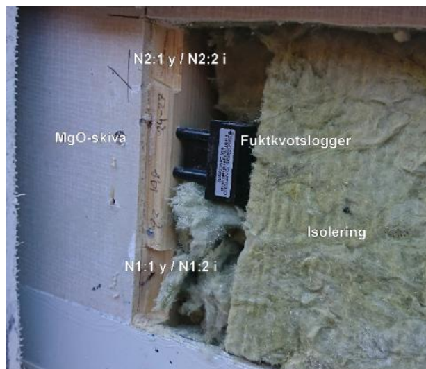
Figur 33 Fotografiet visar en fasad där den putsbärande skivan och del av MgO-skivan har monterats bort. Isoleringen är blottad och en liten del av den bärande trästommen syns bakom MgO-skivan. Uttaget prov från trästomme togs vid markering, N2:1 y / N2:2 i samt N1:1 y / N1:2 i.
